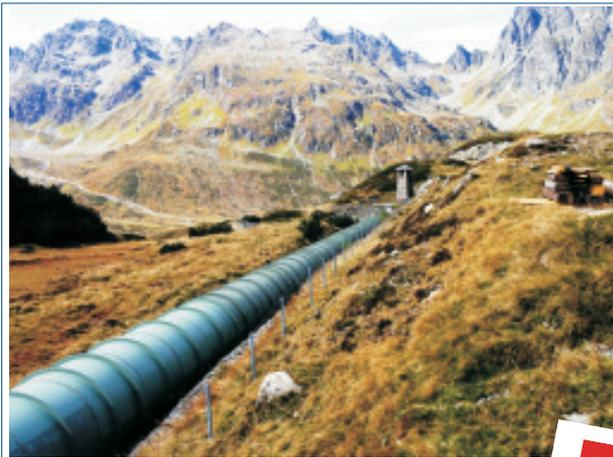
Bild oben: Stromgewinnung aus Wasserkraft: Wasser vom Silvretta-Stausee
